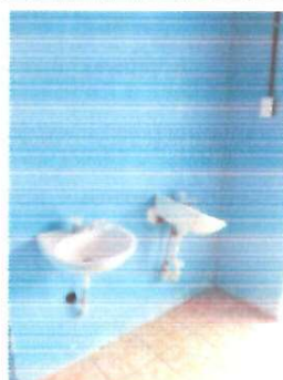
FOTO No.4: SERVICIOS SANITARIOS Y SUS ACCESORIOS. Cambio de accesorios de lavamanos
